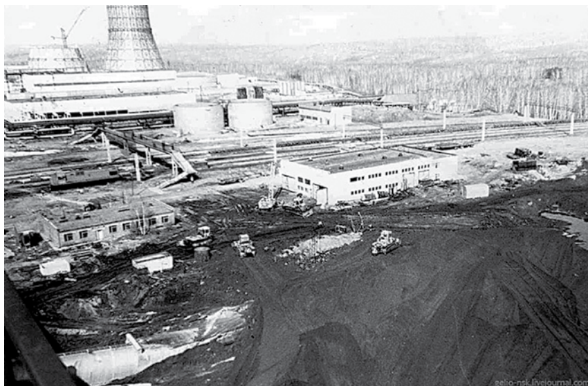
Гидроуглепровод Белово — Новосибирск
